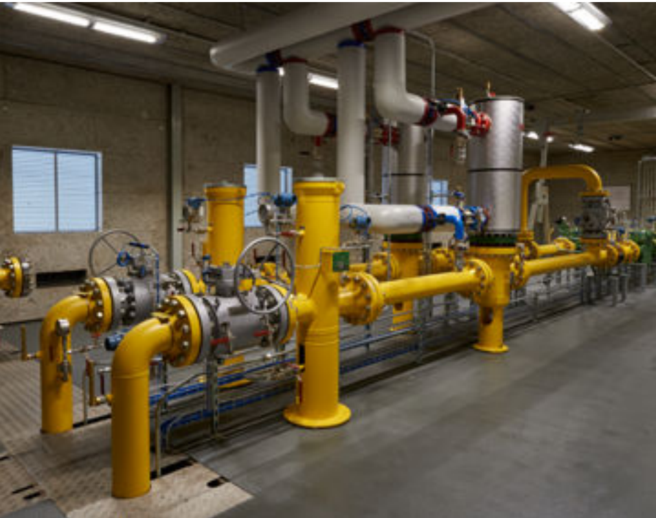
Travaux de modernisation du poste de Choulex / @ Corinne Cuendet.
